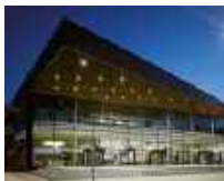
60 Vogtlandhalle (Stadthalle), Greiz/DE
