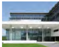
12 Büro- und Geschäftshaus «Hillsite», Schwalbach am Taunus/DE
