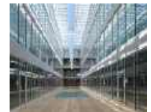
18 Universität Lausanne «Géopolis», Lausanne/CH
