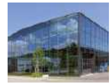
66 Werkhalle Glas Trösch, St.Gallen/CH
