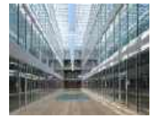
18 Universität Lausanne «Géopolis», Lausanne/CH
