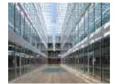
18 Universität Lausanne «Géopolis», Lausanne/CH
