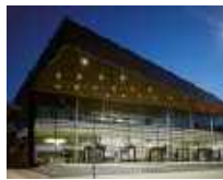
60 Vogtlandhalle (Stadthalle), Greiz/DE
