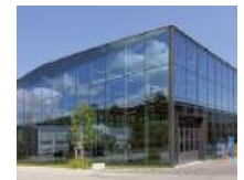
66 Werkhalle Glas Trösch, St.Gallen/CH
