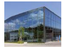
66 Werkhalle Glas Trösch, St.Gallen/CH
