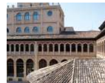
15 Informationsgebäude der Universität Zaragoza, Zaragoza/ES
