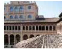
15 Informationsgebäude der Universität Zaragoza, Zaragoza/ES
