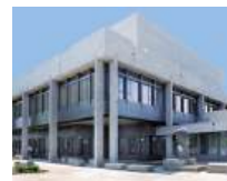
24 Universität St.Gallen, St.Gallen/CH
