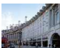
9 Gebäudesanierung, Regent Street, London/GB
