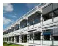
15 Universität Saarbrücken, Gebäude B41, Saarbrücken/DE.
