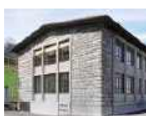
10 Pumpwerk Schönau, WVRB AG, Bern/CH
