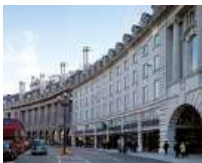
9 Gebäudesanierung, Regent Street, London/GB
