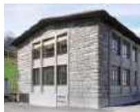
10 Pumpwerk Schönau, WVRB AG, Bern/CH
