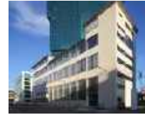
6 Umbau Bürogebäude «Diagonal», Zürich/CH
