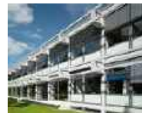
15 Universität Saarbrücken, Gebäude B41, Saarbrücken/DE.
