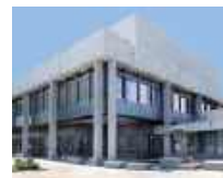
24 Universität St.Gallen, St.Gallen/CH
