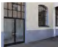
28 Heizhaus Brosswaldengasse, Bregenz/AT
