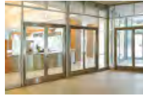
5 Frank O. Gehry Building «Novartis Campus», Basel/CH
