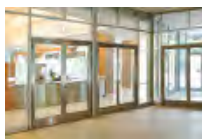
5 Frank O. Gehry Building «Novartis Campus», Basel/CH
